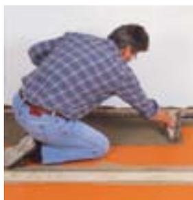
7. Subito dopo l'applicazione della guaina **Schlüter®-DITRA** e dopo aver steso un sottile strato di colla, è possibile posare la pavimentazione. In corso d'opera rasare le cavità con la parte liscia della spatola e stendere il collante con la parte dentata della stessa.
