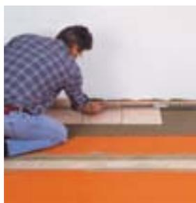
8. La dentatura della spatola dipende dal formato delle piastrelle. Durante questa operazione è necessario rispettare i tempi di esposizione della colla.
