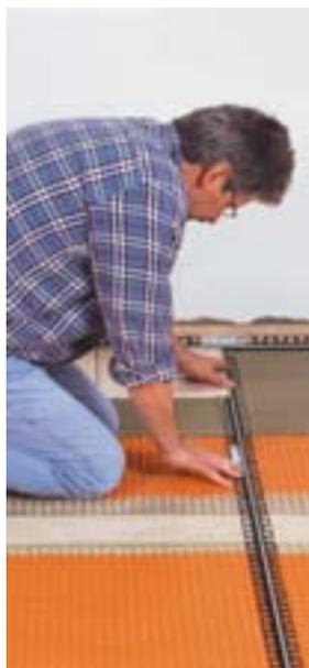
9. In conformità alle norme di applicazione in vigore devono essere applicati i giunti di dilatazione nella pavimentazione. Si consigliano i giunti della serie **Schlüter®-DILEX**.
